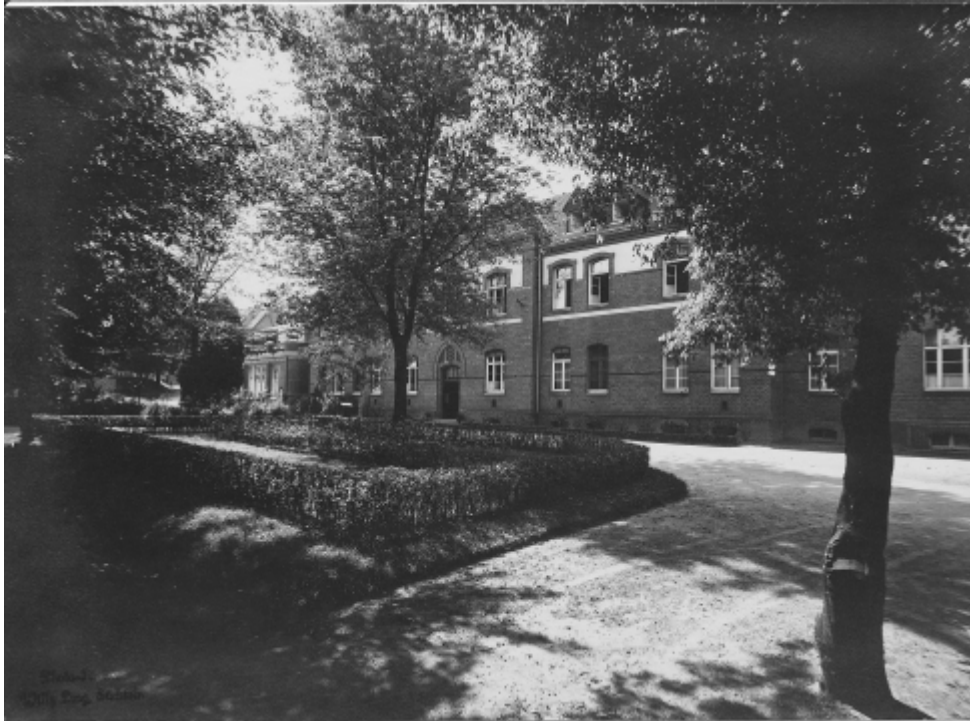
Der frühere Haupteingang der Orthopädie Fotos: LVR-Klinik für Orthopädie Viersen
