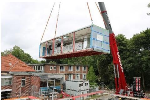
**Der Gebäudeanbau, in dem die beiden neuen OP-Säle beheimatet sind, besteht aus insgesamt 13 Modulen.**
